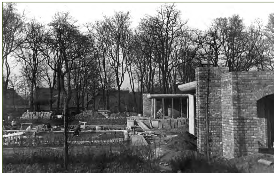
Abb. 188 Armiereisen auf dem geschwungenen Dach beim Pergolabau, 1929
