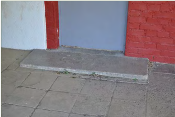
Abb. 161 Originaler Kunststeinplattenbelag unter der Pergola von 1930, ausgebessert mit simplen Betonplatten, 2015
