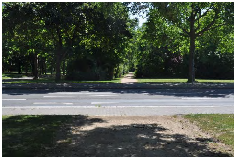
Abb. 122 Bankplätze an den Längswegen mit Betonplatten und Mosaikpflaster-Flickstellen, 2015
