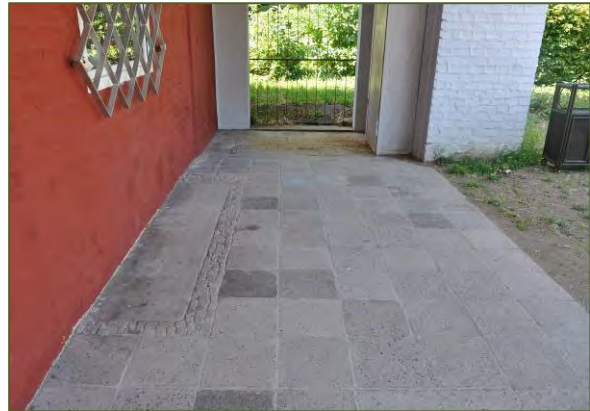
Abb. 161 Originaler Kunststeinplattenbelag unter der Pergola von 1930, ausgebessert mit simplen Betonplatten, 2015
