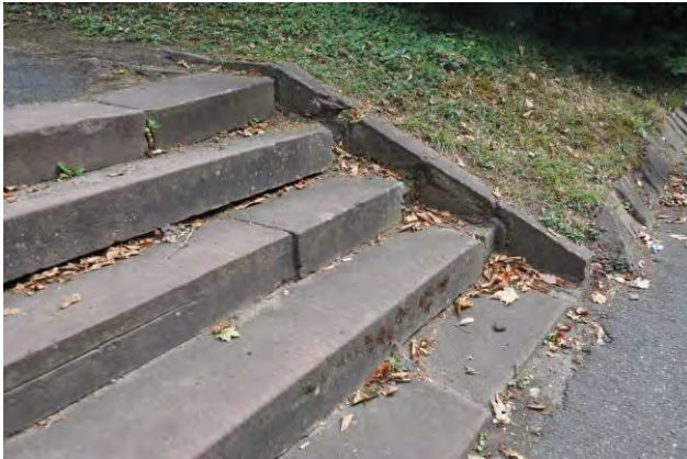
Abb. 66 Treppe an Salvatorstraße West
