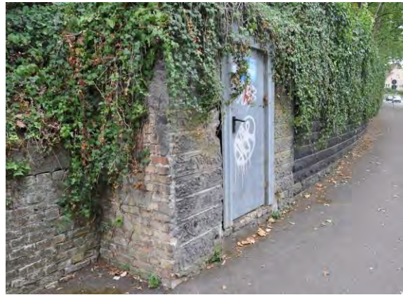
Abb. 65 Mauer Salvatorstraße Nord
