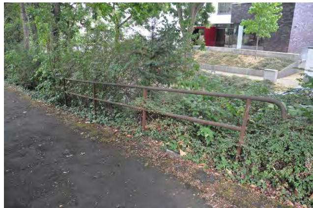
Abb. 71 Geländer oberhalb der Böschung Auf der Steig
