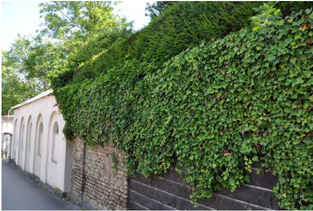
Abb. 64 Mauer Salvatorstraße West
