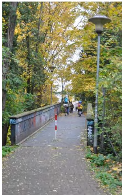
Abb.213 Brücke am Ravelin 2015
