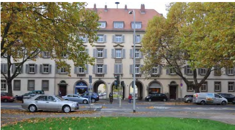
Abb. 203 Torbau mit Peitschenleuchte, Ampel und parkenden Autos,
