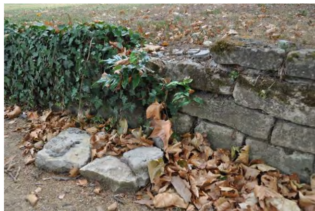
Abb. 68 Trockenmauer Panoramaweg
