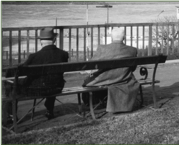
Abb. 7 Bankgestell aus gebogenem Flacheisen, Holzlehne und -sitzfläche, Rheinterrasse 1950er Abb. 8 Musterblatt für Gartenbänke um 1912
