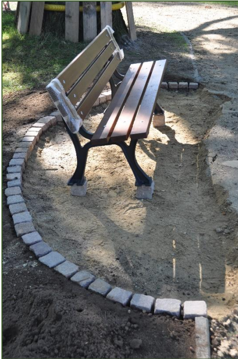
Abb. 17, 18 Umgestaltung der Sitznischen in segmentbogenförmiger Ausführung mit einzeliger Natursteinkante, mit Anschluss an Bestandskantensteine der Wegeeinfassung; Kurpark Bad Homburg, 2011, 2015
