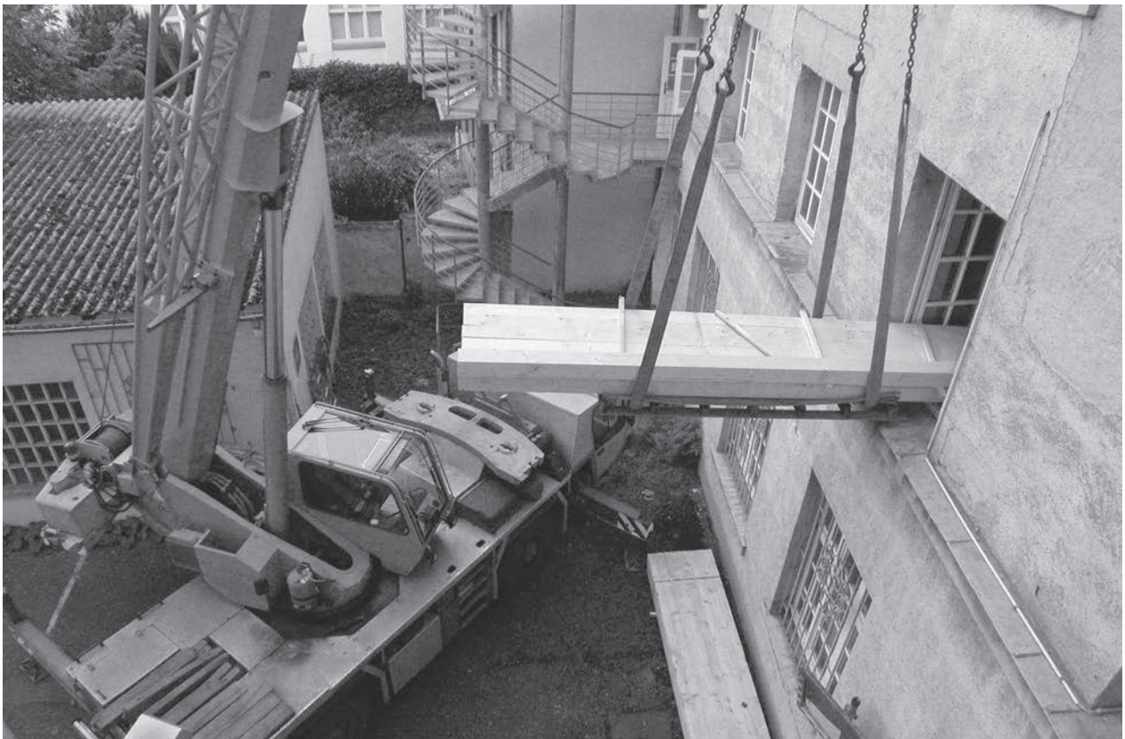
Abb. 1: Anlieferung von Holzstützen. Die Deckensanierung im Gebäude Rheinallee 3 B brachte ab Sommer 2015 erhebliche Einschränkungen für die Benutzung des Stadtarchivs (Foto: © Wolfgang Dobras).
