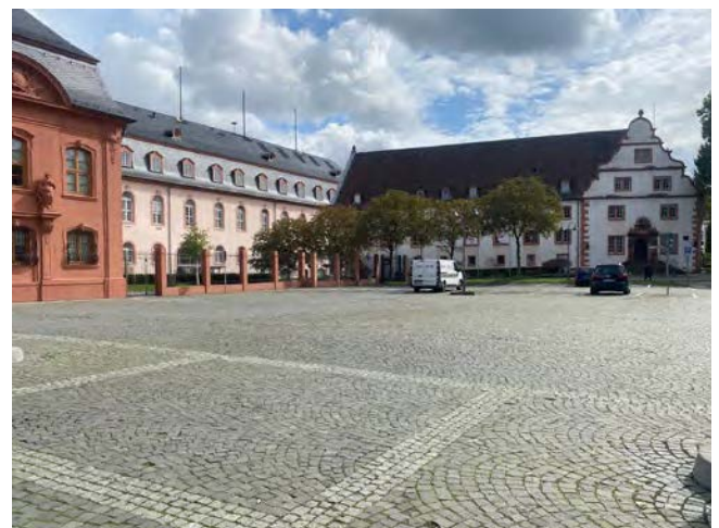
Abb. 129: Deutschhausplatz während der Pflasterarbeiten in Richtung Zeughaus
