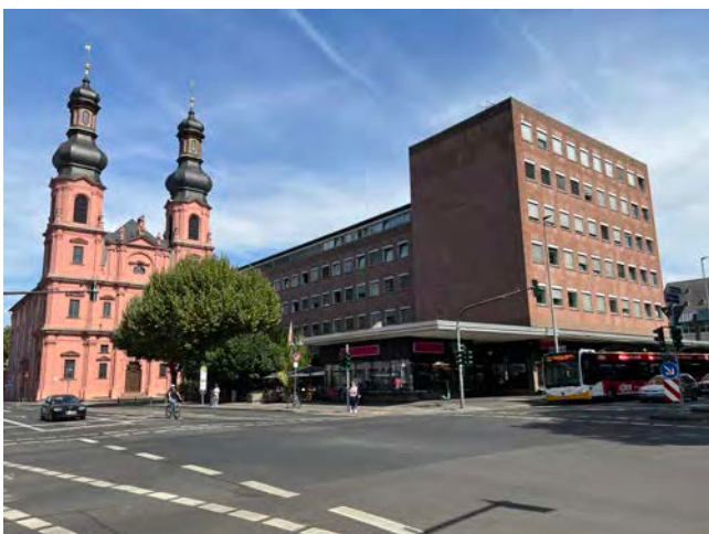
Abb. 117: Blick in Richtung St. Peter mit Pavillonanbau Allianzhaus
