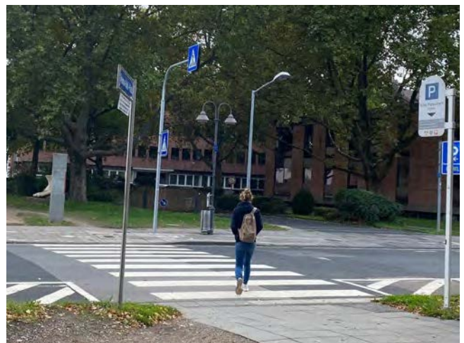
Abb. 93: Beleuchtung der Fußgängerüberwege im Bearbeitungs-gebiet
