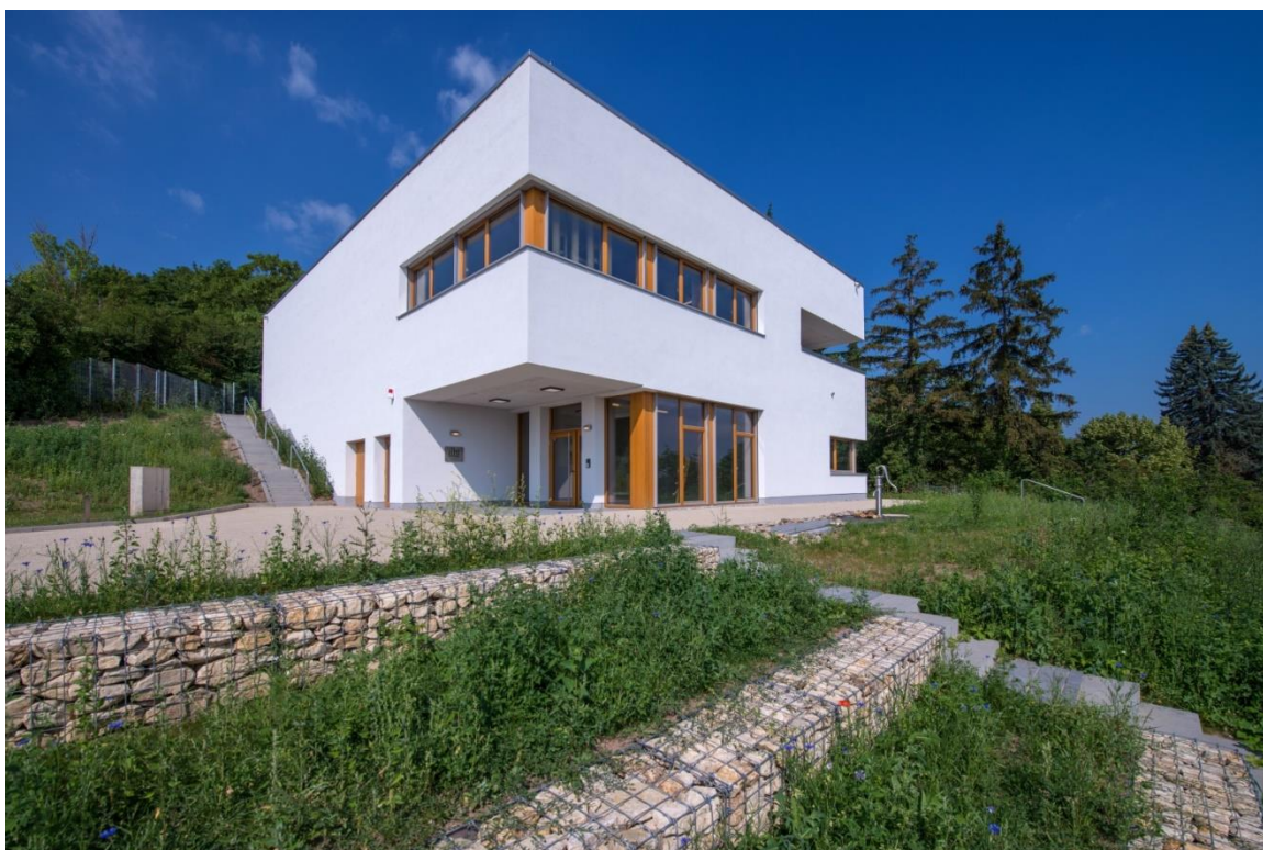
Abbildung 53: Umweltbildungszentrum Weisenau (Quelle: Entsorgungsbetrieb der Stadt Mainz)
