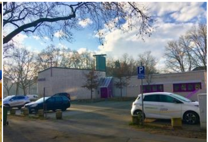
Abbildung 36: UrStromMobil-Station Pauluskirche (Quelle: UrStrom - BürgerEnergieGenossenschaft Mainz eG)
