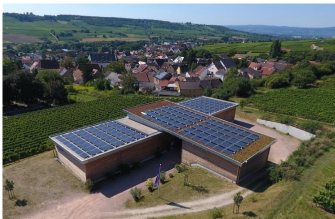
Abbildung 11: UrStrom Bürgersolaranlage auf dem Ökoweingut Huster in Großwinternheim
